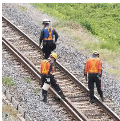
点検・工程管理
